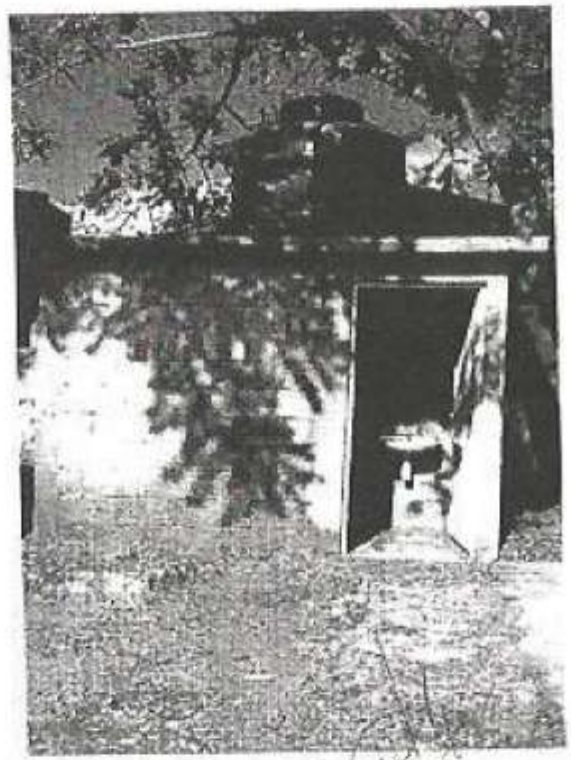
Concepto de obra ejecutado: suministro y colocacion de lavabo y rotoplas
